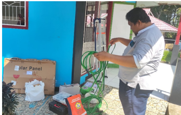
Gambar 5. Pemasangan instalasi kabel dari modul surya ke lampu pada selasar
