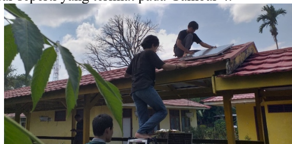
Gambar 4. Pemasangan modul surya
