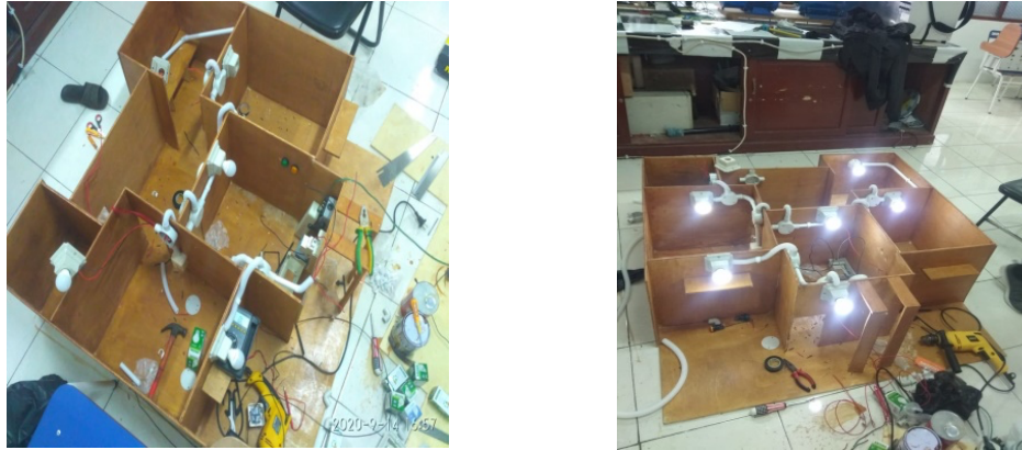
Gambar 4. Pemasangan Instalasi Penerangan pada Miniatur Rumah Sederhana
