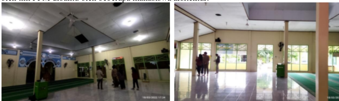
Gambar 3. Kegiatan Survei dan Pengukuran Data Eksisting Masjid Darussalam
