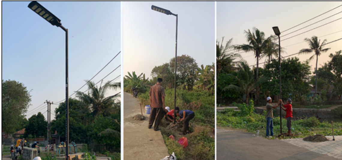
Gambar 3. Pemasangan Lampu PJUTS
