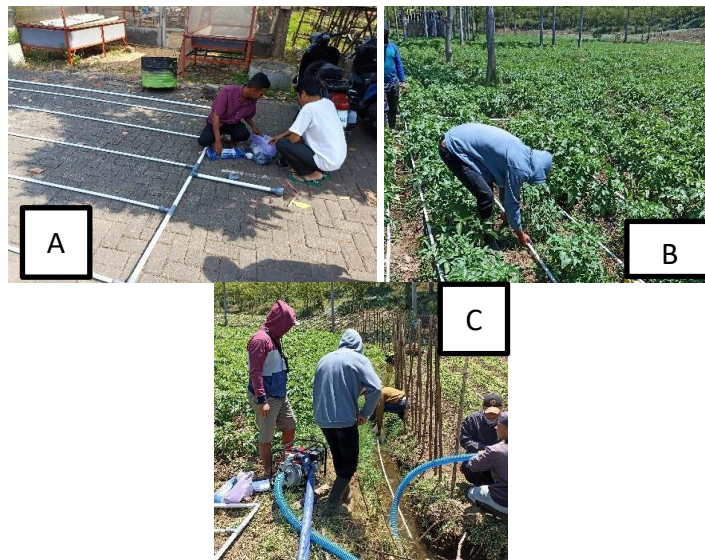
Gambar 6. Proses Instalasi Alat Sistem Drip Irigasi beri keterangan setiap gambar A. Kalibrasi Alat; B. Instalasi Pipa Irigasi di Bedengan; C. Instalasi Pompa Air
