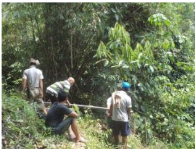
Gambar 4. Pemasangan jaringan pipa masukan
