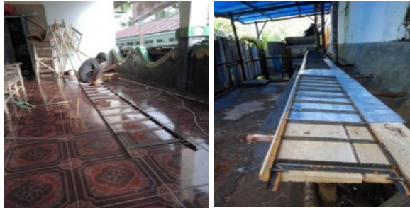
Gambar 3. Persiapan begisting cetakan batu alam buatan
