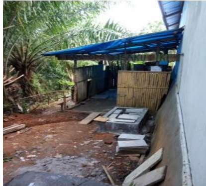
Gambar 1. Persiapan bedeng kerja IbM
