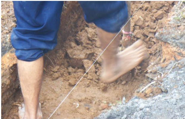
Gambar 7. Tukang Bekerja Menggali Tanah Tanpa Alas Kaki
