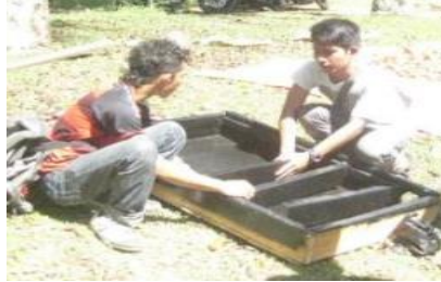
Gambar 9. Pengecatan dan pemasangan sirip pengalir udara pada absorber
