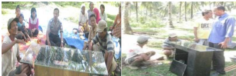
Gambar 14. Pemasangan kaca pelapis bagian atas rumah kaca
