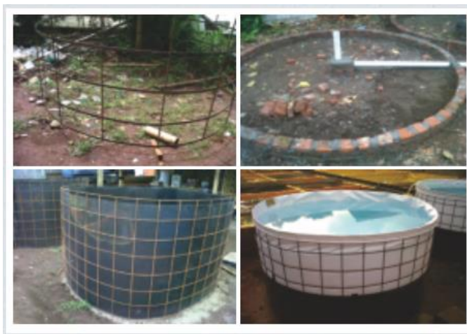
Gambar 1. Tahapan konstruksi kolam
