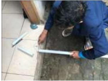
Gambar 9. Pematongan Pipa
