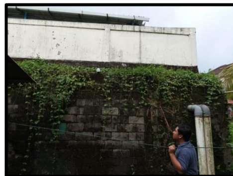
Gambar 12. Dinding Penahan Tanah Bagian Belakang Kantor
