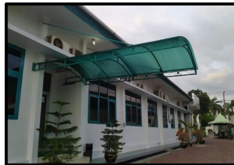
Gambar 33. Letak kanopi di sisi kanan gedung
