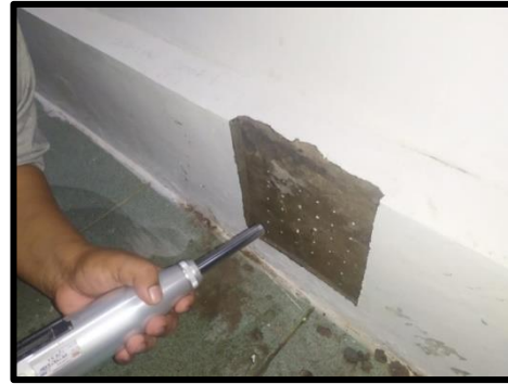
Gambar 19. Dokumentasi Pengujian Hammer Test
