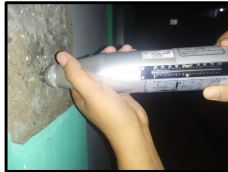
Gambar 20. Dokumentasi Pengujian Hammer Test
