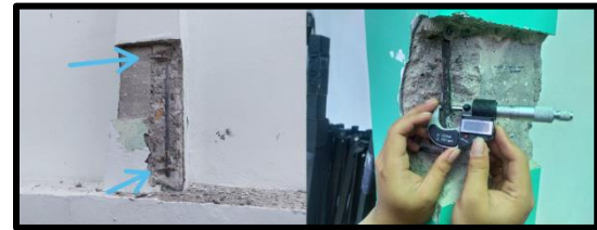
Gambar 24. Dokumentasi Pengukuran Tulangan Kolom Secara Langsung
