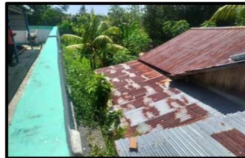
Gambar 17. Rumah Warga yang Berada didekat Dinding Penahan Tanah
