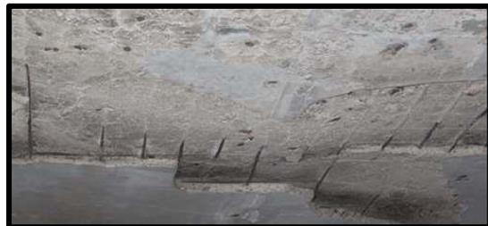
**Gambar 11.** *Spalling* pada Plat Lantai
