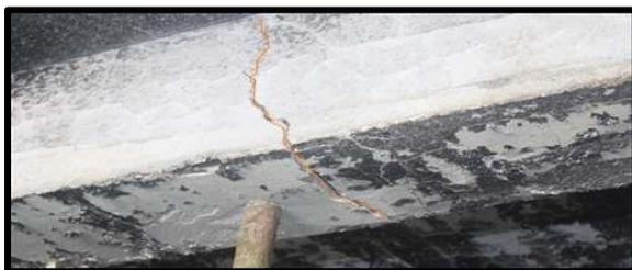
**Gambar 7.** Retak pada Balok
