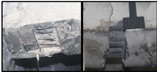
**Gambar 9.** *Spalling* pada Balok
