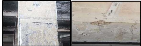
**Gambar 6.** Perubahan warna pada beton
