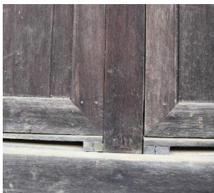
Gambar 4. Elemen Balok Sloof dan Kolom Kayu Rumah Ibu Kabat
