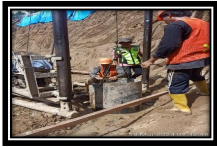
Gambar 5. Pemasangan casing
