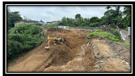
Gambar 3. Pekerjaan Tanah galian dan timbunan
