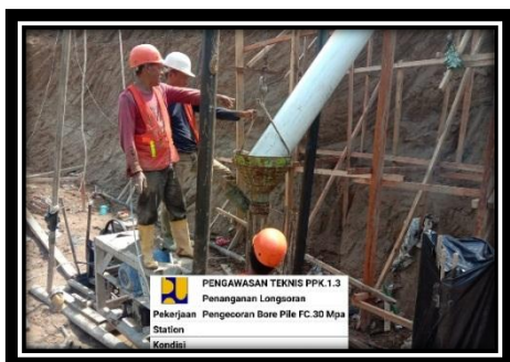
Gambar 7. Pengecoran
