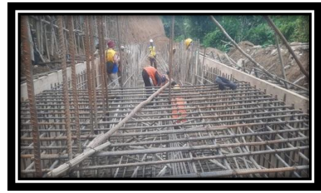
Gambar 9. Pekerjaan Pile Cap
