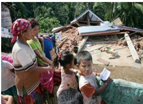
Gambar 1. Foto kerusakan bangunan akibat gempa bumi 12 September 2007
