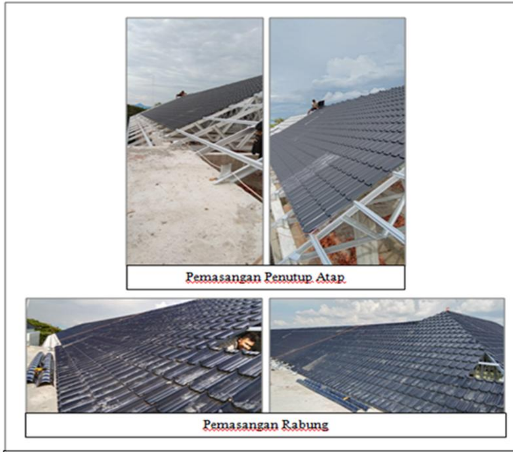
Gambar 3. Tahap Pengerjaan Pkerjaan Penutup Atap dan Pemasangan Rabung
