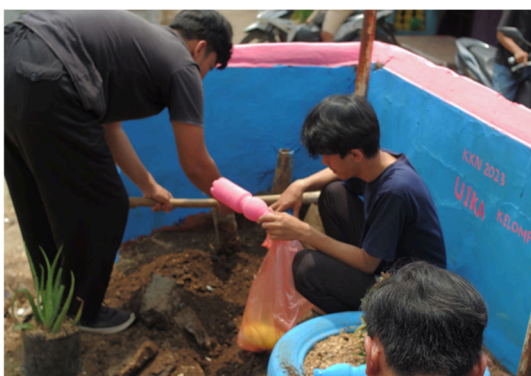
Gambar 2. Proses pemerataan tanah di SDN Bojong Rongkas 03
