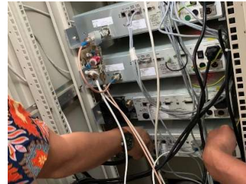
Gambar 7. Pemasangan Kabel Coax pada Relay
