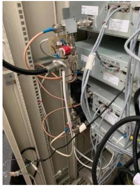
Gambar 15. Pemasangan Relay setelah Perbaikan
