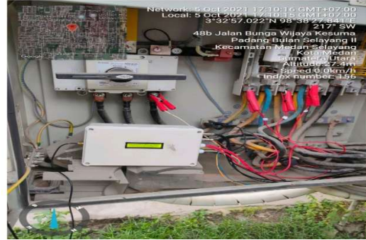
Gambar.3 Pemasangan Alat Ukur Pada Gardu Distribusi
