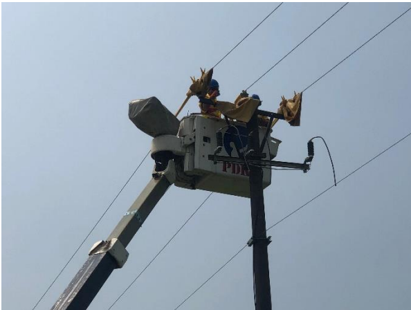
Gambar 5. Kegiatan Pemasangan Arrester
