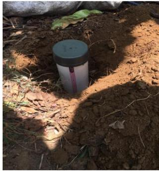
**Gambar 3. Peletakan Media Biopori Menggunakan PVC**
