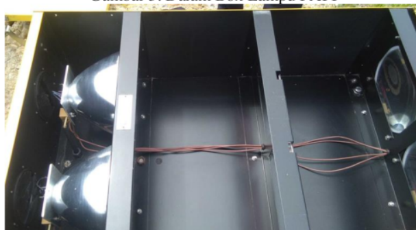
Gambar 4. Dalam Box Lampu PAPI dari posisi atas
