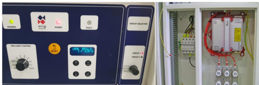
Gambar 7. Display Kontrol CCR dan Wiring Diagram CCR to PAPI
