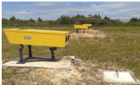
Gambar 2. Posisi PAPI Pada Landasan
