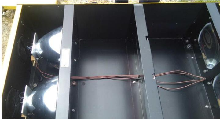
Gambar 4. Dalam Box Lampu PAPI dari posisi atas
