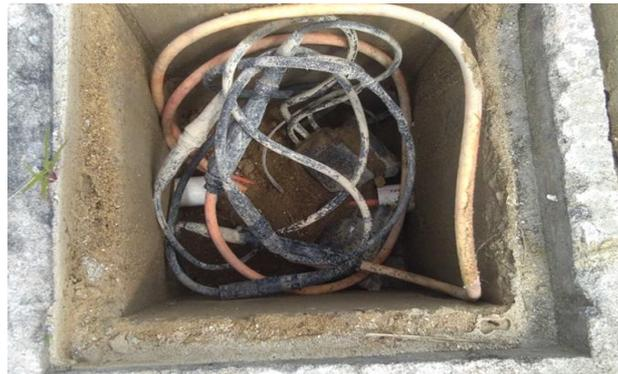
Gambar 5. Bak Kontrol dan Trafo Series
