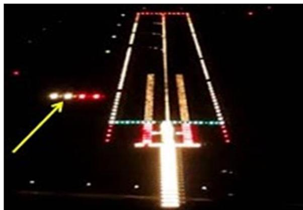
Gambar 6. Posisi PAPI terlihat dari pesawat
