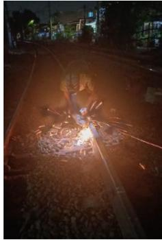
**Gambar 7.** Proses Penghalusan Sambungan
