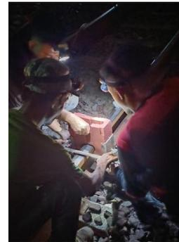
**Gambar 5.** Pemasangan Cetakan Las *Thermit*
