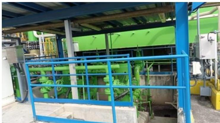
**Gambar 2.** Pompa kondensat
