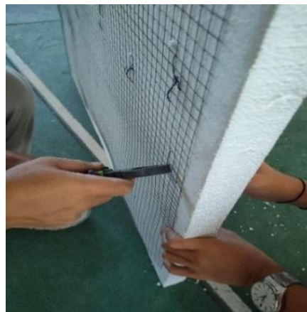
Gambar 4. Pemasangan Kawat
