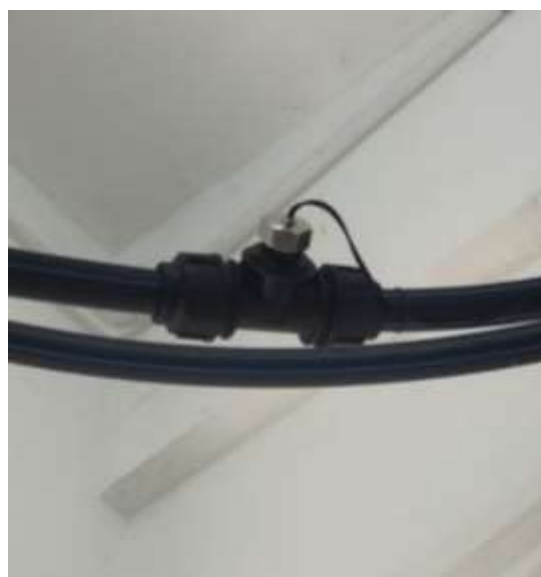
Gambar 5. Hasil jadi pemasangan sensor
