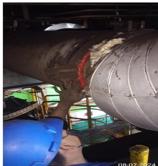
Gambar 5. Hasil dari perbaikan sambungan pipa aliran batu bara
