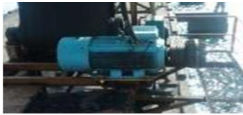
G.19 Motor penggerak konveyor
