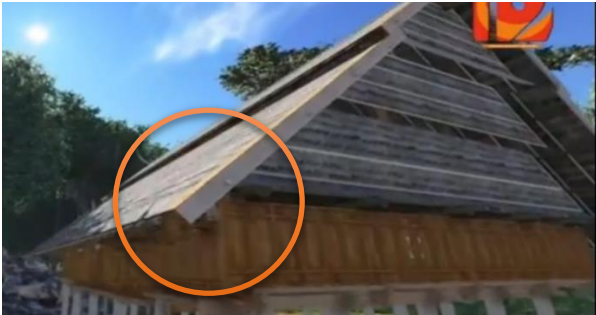
Gambar 4. Overstek pada rumah adat Karampuang Sumber : dokumentasi penulis, 2020
