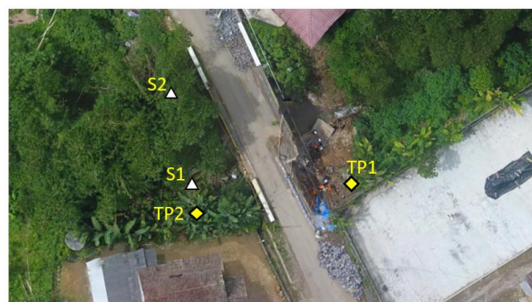
Gambar 2. Penyelidikan tanah di sekitar jembatan
