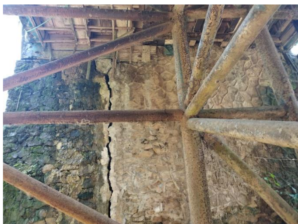
Gambar 1. Retakan pada sambungan abutmen lama dan baru sesaat sebelum longsor
