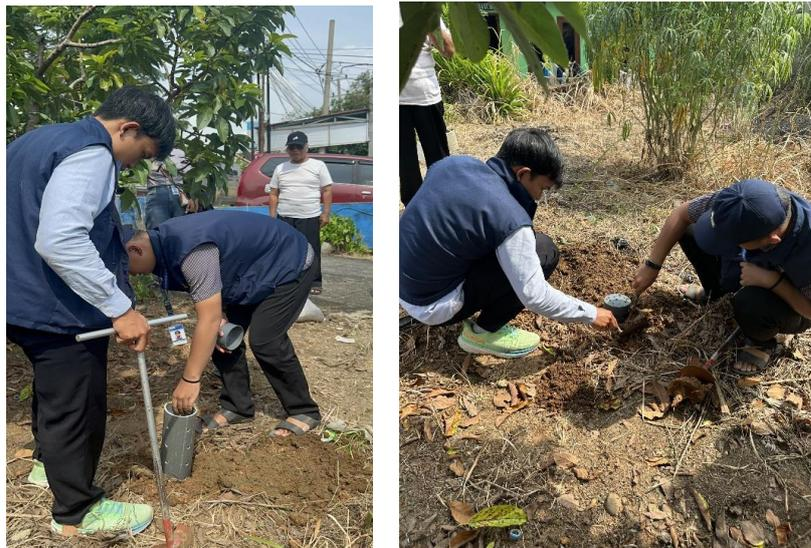
**Gambar 4.** Pemasangan biopori
